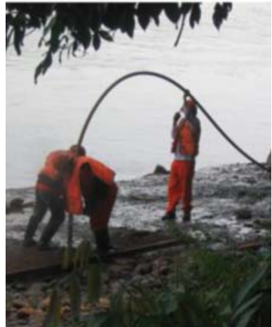
Figura 7. Perforando utilizando el taladro
