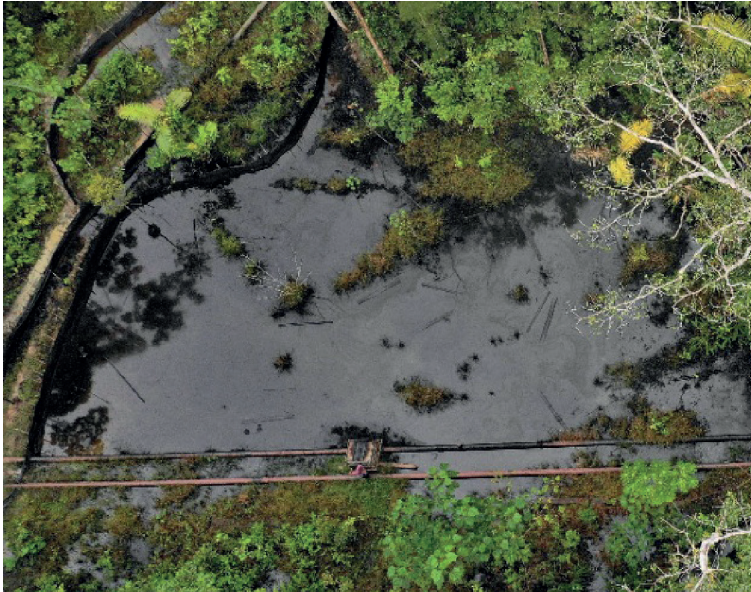
Figura 1. Tubos, oleoducto Lote 8 (Zúñiga Lossio y León Cepeda, 2021, p. 54).
