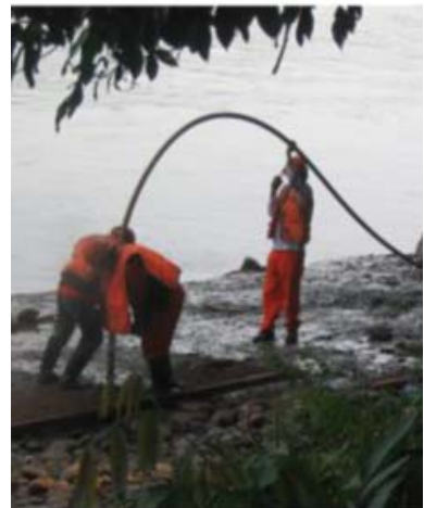
Figura 7. Perforando utilizando el taladro
